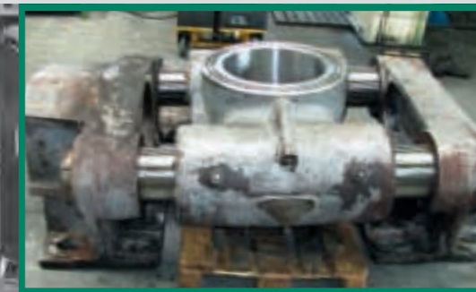
Reparatur eines Schiebeschlittens für ein Zementwerk, Stückgewicht etwa 10 Tonnen, Abmessung: 2.200 x 1.300 x 780 mm: Ausdrehen des Lagersitzes, Anfertigung von Ausgleichshülse, Labyrinthtring, Abschlussdeckel und passendem Lagerzapfen
