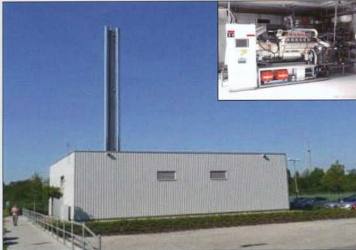
Neue Energiezentrale mit BHKW in Ladenburg
