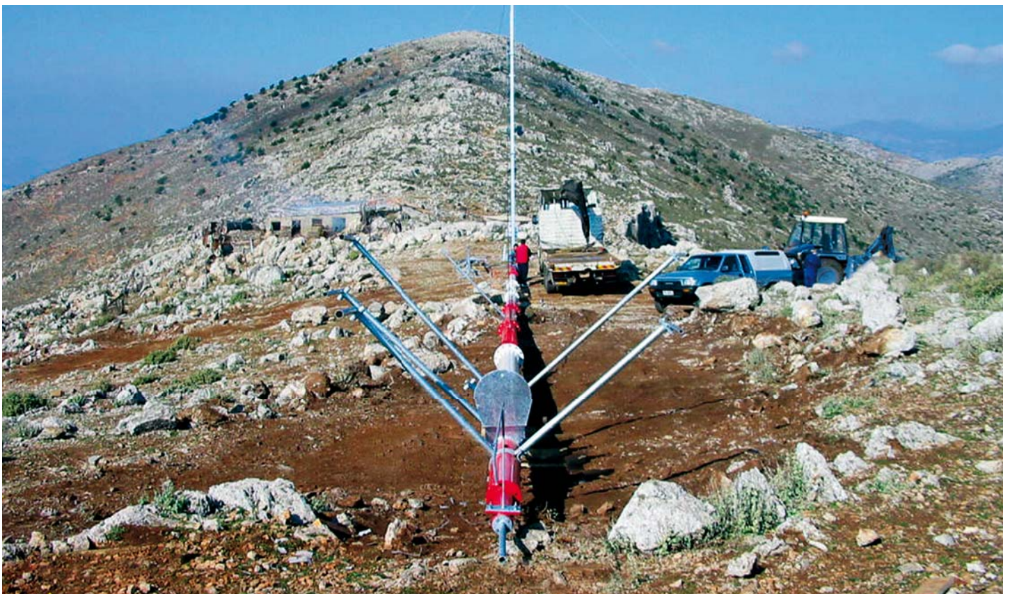
Bei trockenem Boden wie in Griechenland gewährleisten Betonbetten eine feste Verankerung.
