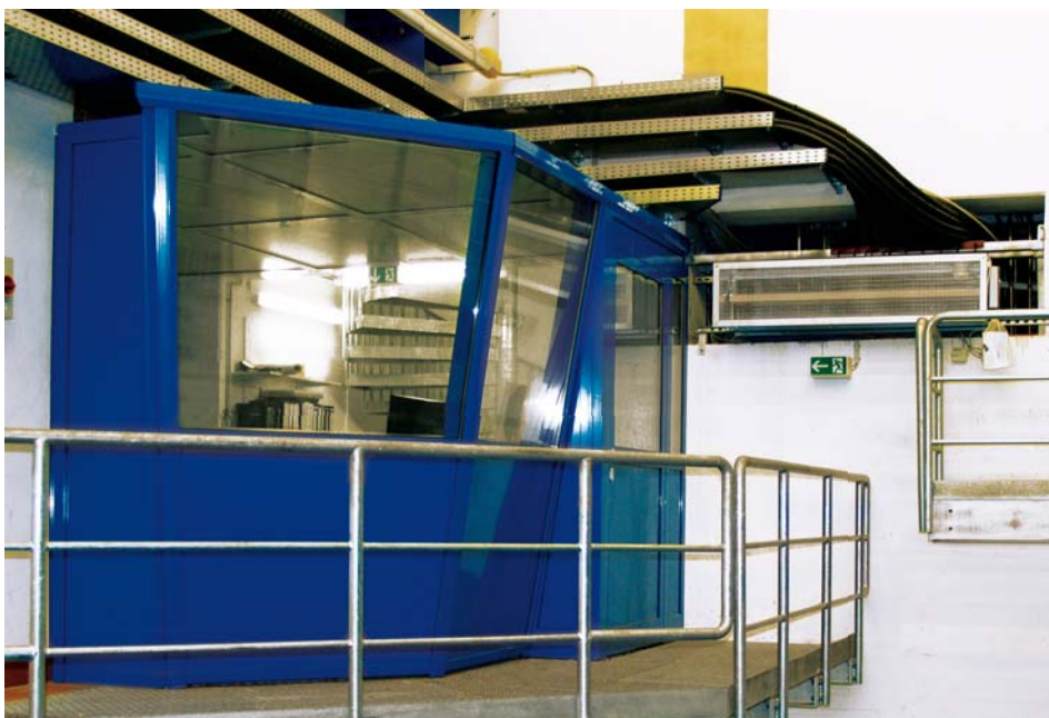
Die Leitwarte im Krafthaus wurde von IHNEN AURICH gefertigt und montiert.
