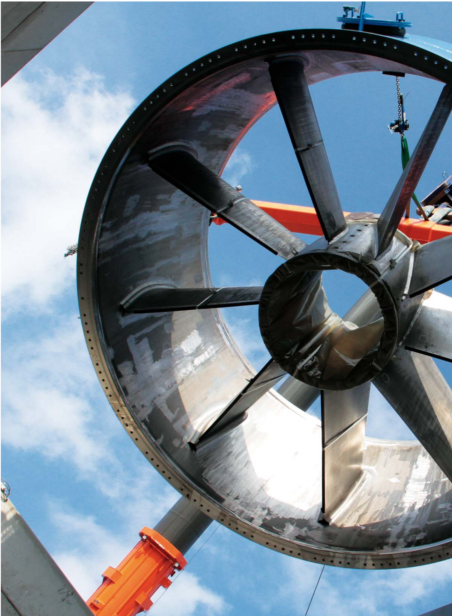
Das Leitwerk der Turbine erreicht den Kraftraum über Dachluken, die von Stahldächern von IHNEN AURICH verschlossen werden.
