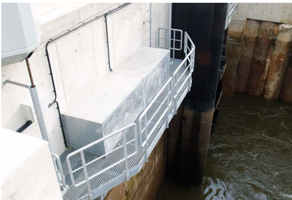
Das Podest am hinteren Schleusentor wurde ohne Hilfskonstruktion montiert.
