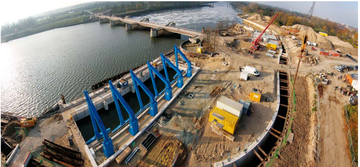
Die Baustelle am Weserwehr (hinten links) während der Arbeiten. Rechts ist bereits der Fischpass zu sehen.
