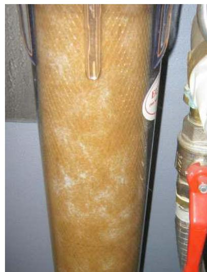
Abb.3: Rotbraune Vorfilter sind sichere Indikatoren für Schäden durch Korrosionsverschmutzung.
